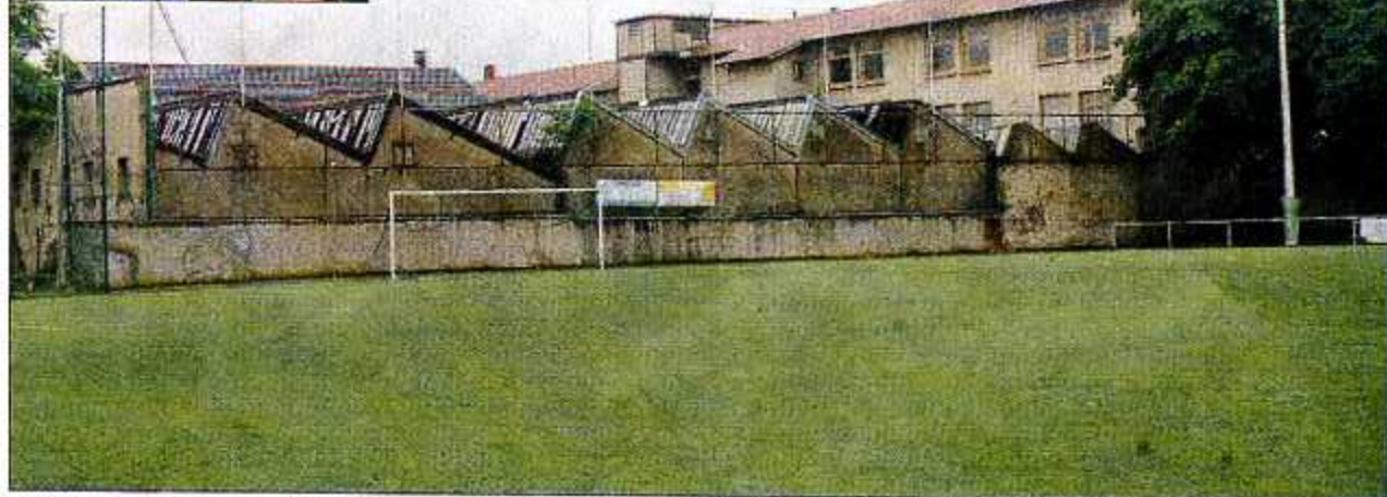
L'usine désaffectée, située derrière les cages sur la photo, sera détruite pour étendre le stade Foe utilisé par l'AS Montchat. En médaillon, Abdel Achache est venu rencontrer les dirigeants de l'AS Montchat pour leur expliquer le projet d'extension du stade Foe et annoncer l'augmentation de leur subvention / Photo Dominique Caron
