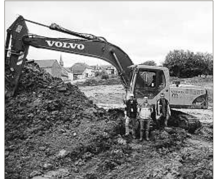
Un important chantier de terrassement pour un nouveau lotissement.
